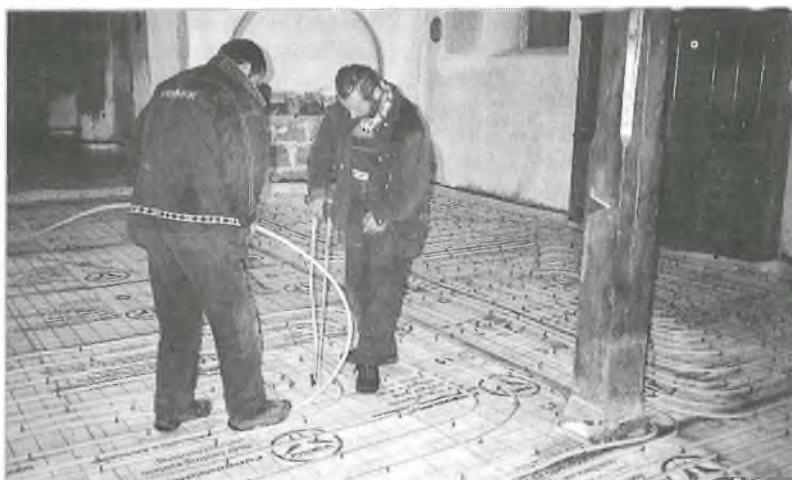
Verlegung der Heizungsrohre durch die Hydrauliker
