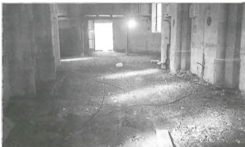
Eine "Kirche ohne Boden" (Zustand Ende Sept. 1998)
