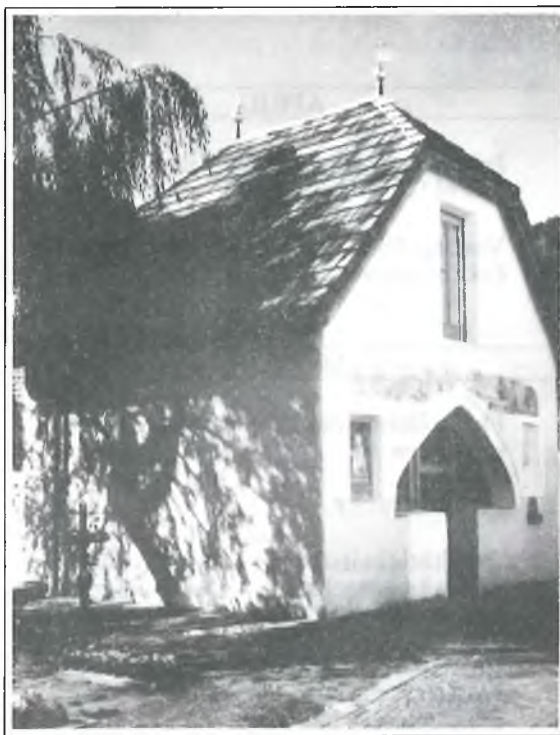
Friedhofskapelle St. Peter - nach der Restaurierung im neuen Kleide
