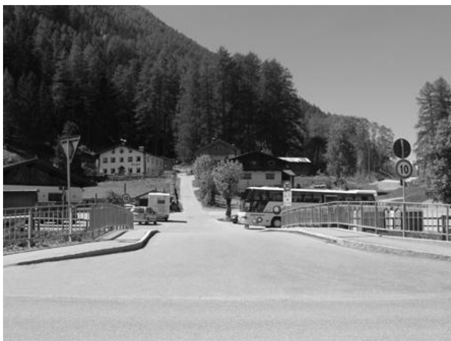
Zufahrt zur Talstation Klausberg: Die neue Brücke
