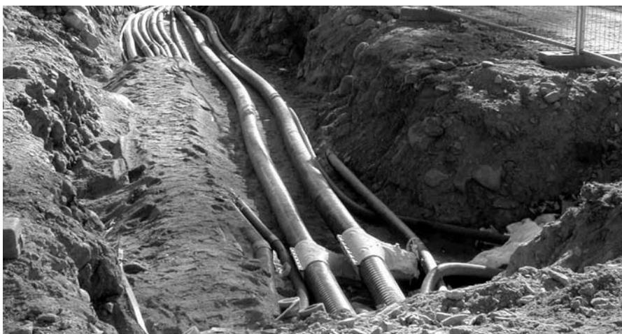
Verlegung von Rohrleitungen
