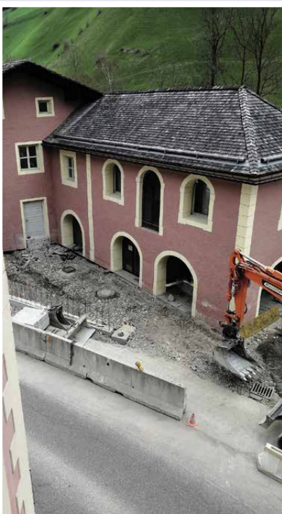
Bau Gehsteig Pfisterhaus
