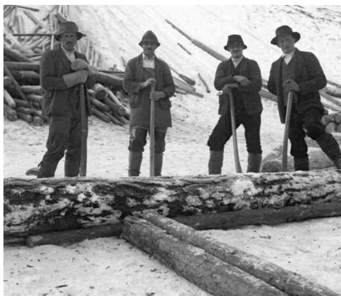
Holzarbeiten am Stöckma Rua
