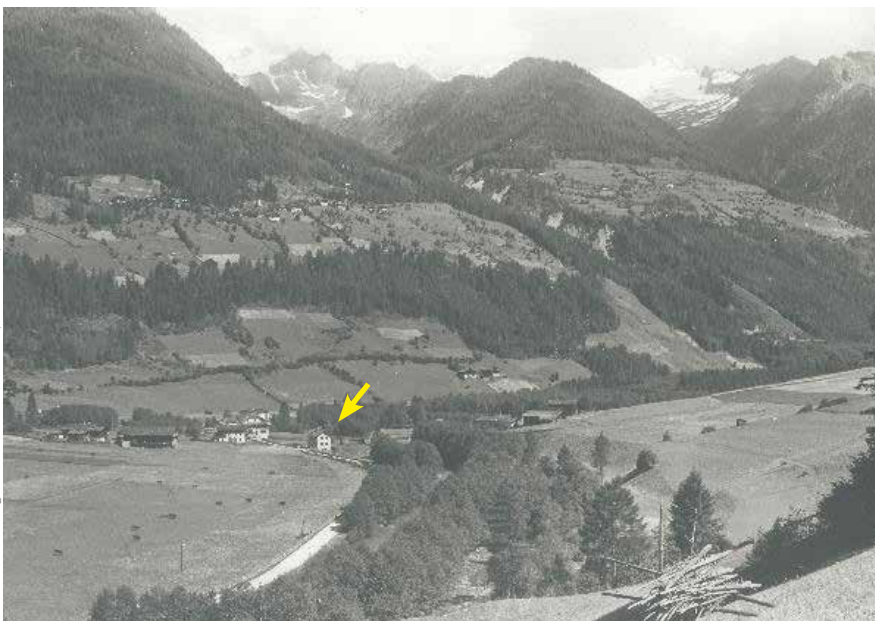
Die ehemalige Gipshütte im Mairboden. Später Wohnhaus, Postamt und „Dopolavoro“, dann Hotel Post, jetzt Pension Olympia.
