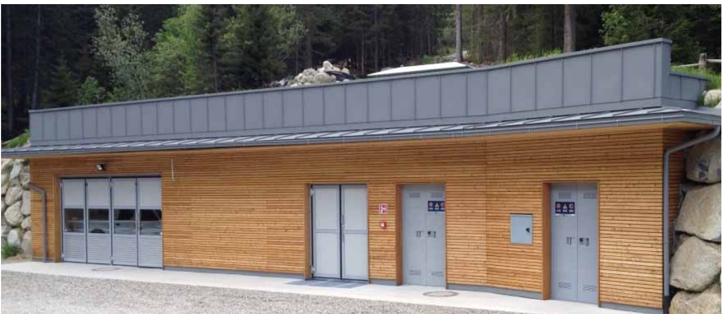
Außenansicht des Krafthauses
