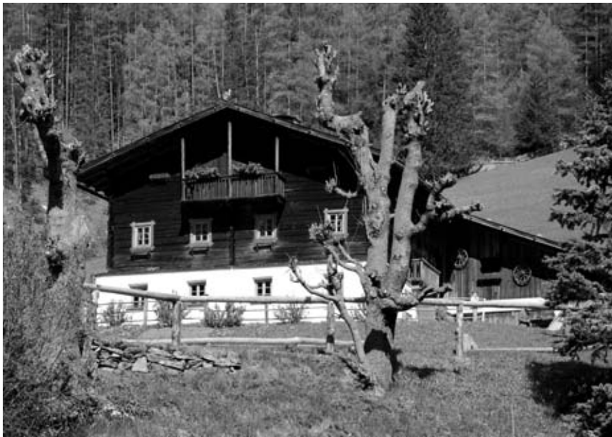
Mustergültig saniertes Bauernhaus im Ahrntal
